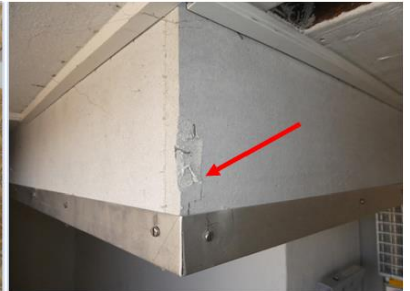
Pressplatten als Belüftungskanal
